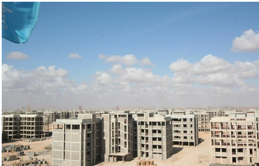
中建利比亚班加西富德15000套住宅工程施工现场
